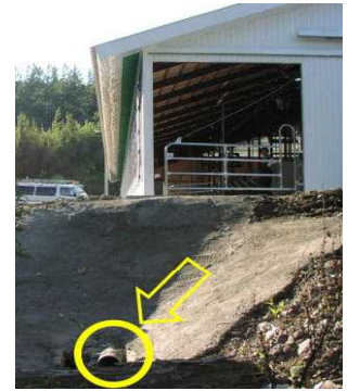
写真5 屋外までつなげた水槽排水パイプ
