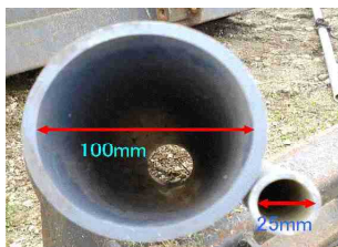
写真10 配管口径の違い 改善前（右）、改善後（左）
