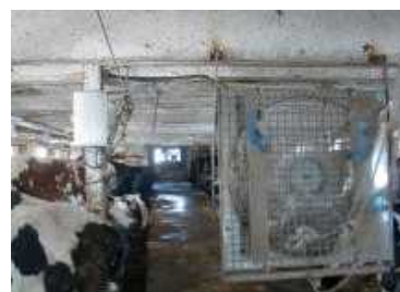
写真18 縦走換気で空気の流れ をつくる
