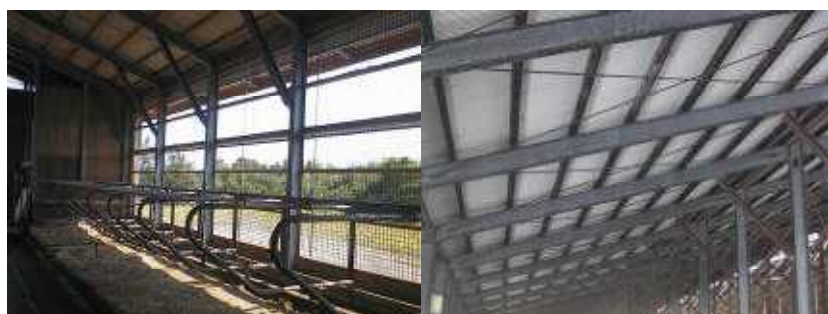
写真4 夏季間は側面を全面開放できる構造にする
