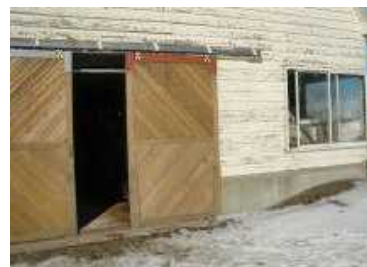
写真19 冬でも窓扉も開ける （写真18の牛舎）
