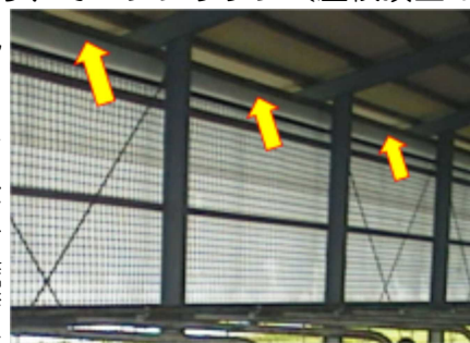
写真3 軒下に開けられた入気口（牛舎長さで連続して開いている）
