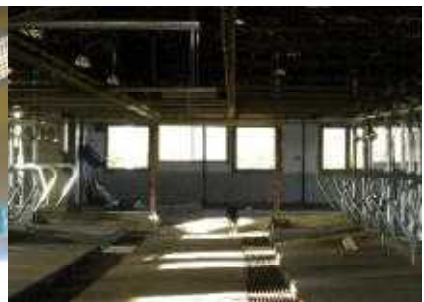
写真8 牛舎幅いっぱいに設置された入気口（改造）
