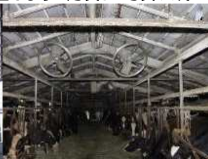
写真10 つなぎ牛舎（吊り下げタイプ）
