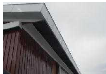
写真13 吹雪の吹き込みを防ぐオープンイーブ
