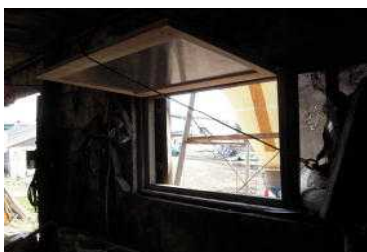
写真17 窓枠の改造で入気でき るようになった事例
