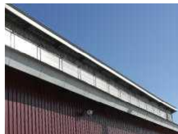
写真15 開口部が締め切られた セミモニター
