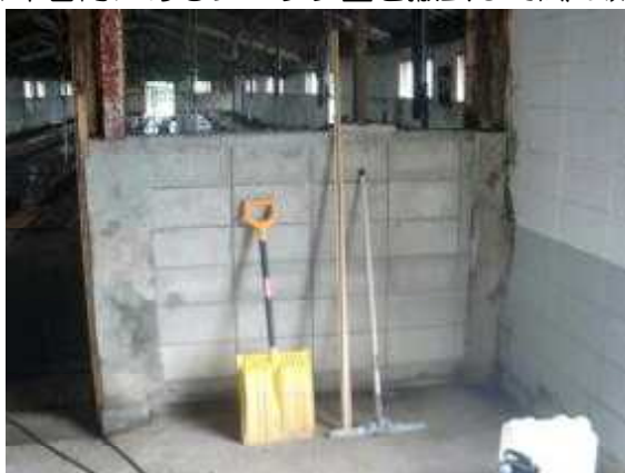
図9 ブロック壁を撤去する前
