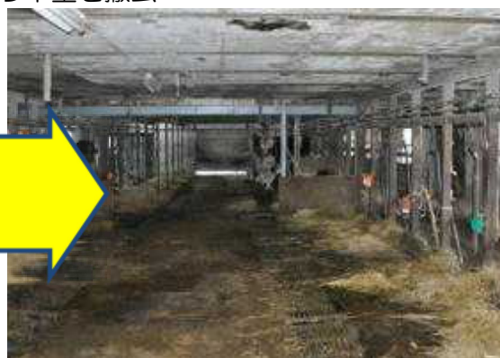
図8 補強を入れて横壁を撤去した事例
