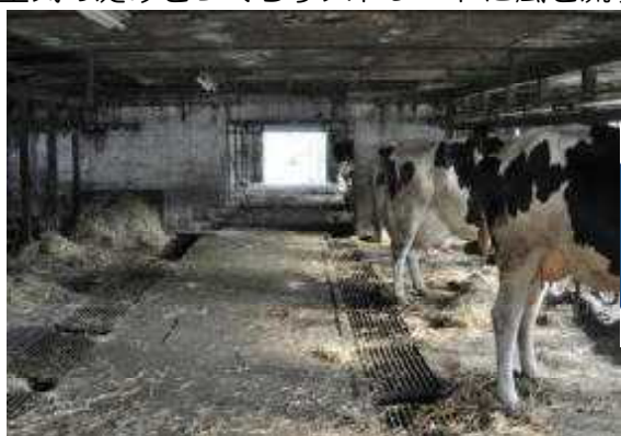
図7 中壁のところで空気の流れが淀んでいた改造前
