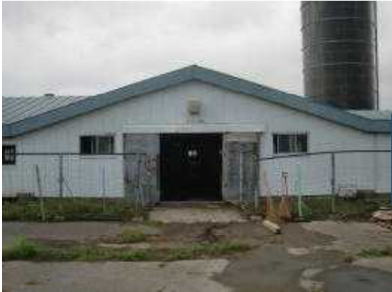
図1 換気扇設置前
