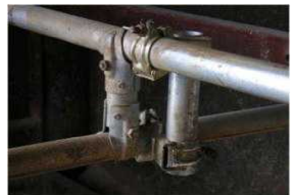
図9 2本のパイプでネックレールを固定した事例（2）
