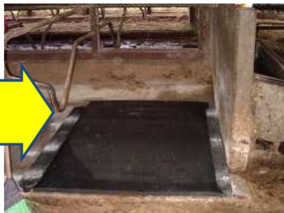
図2 床を平らにならして手前に若干の勾配を付けてから牛床マットを設置
