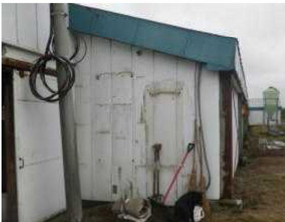
図3 入気口がない改造前
