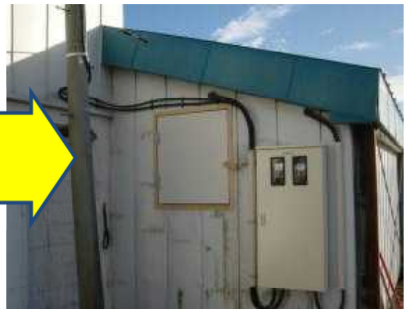
図4 開け閉め可能な入気口を設置後
