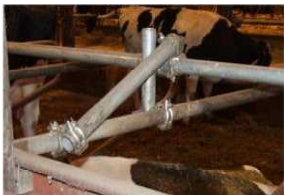
図8 2本のパイプでネックレールを固定した事例（1）
