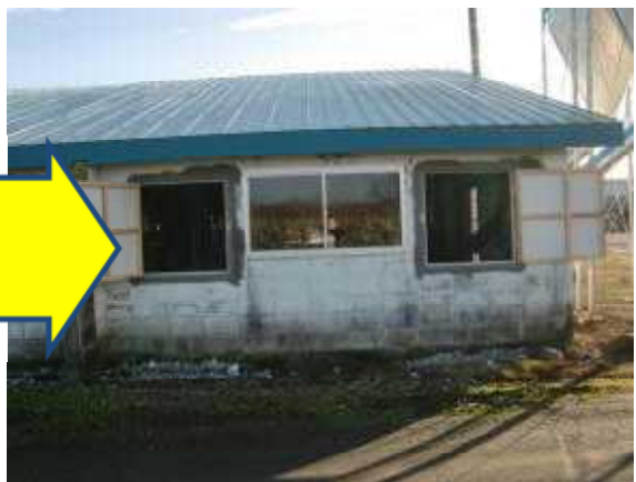
図6 牛舎幅一杯になるよう入気口を設置
