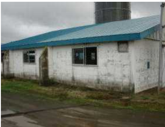
図5 入気口が不足していた改造前
