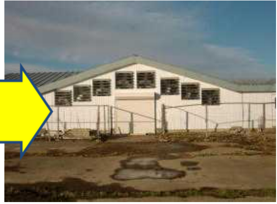
図2 換気扇を8台設置
