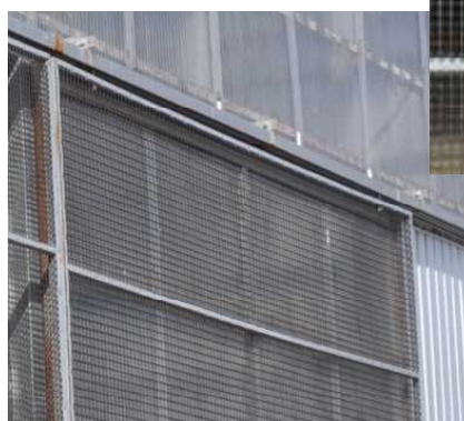
図12 既存扉の外側にレール設置
