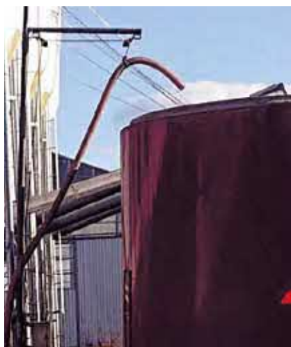
写真 10 ポンプによる加水
