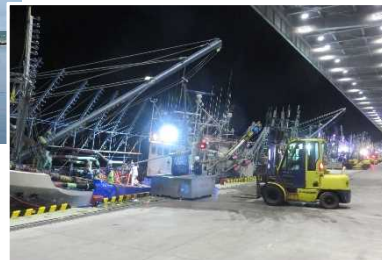
厚岸漁港 屋根付き岸壁・人工地盤
