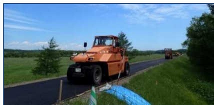
堤防天端舗装の様子 ■堤防の天端舗装を実施
