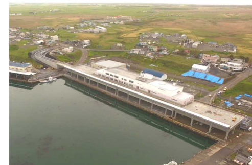
歯舞漁港 屋根付き岸壁・人工地盤 (R4完成予定)
