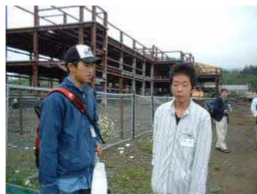
▲建設中の小学校
