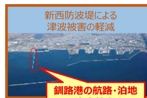
新西防波堤による津波被害の軽減 釧路港の航路・泊地の安全性向上
