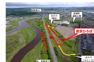
釧路町 緊急広場整備
