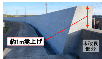
霧多布港 防潮堤改良
