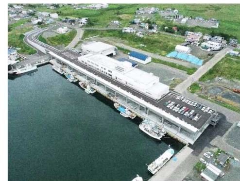
歯舞漁港 屋根付き岸壁・人工地盤 (R4完成)
