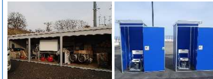
防災資材庫及びマンホールトイレの整備
