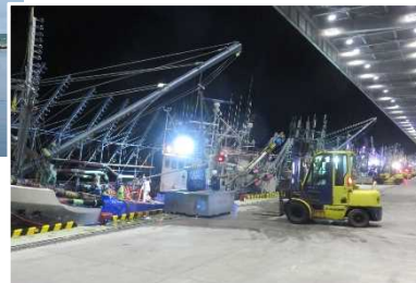
厚岸漁港 屋根付き岸壁・人工地盤
