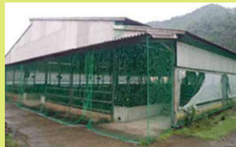
防鳥ネットの設置
